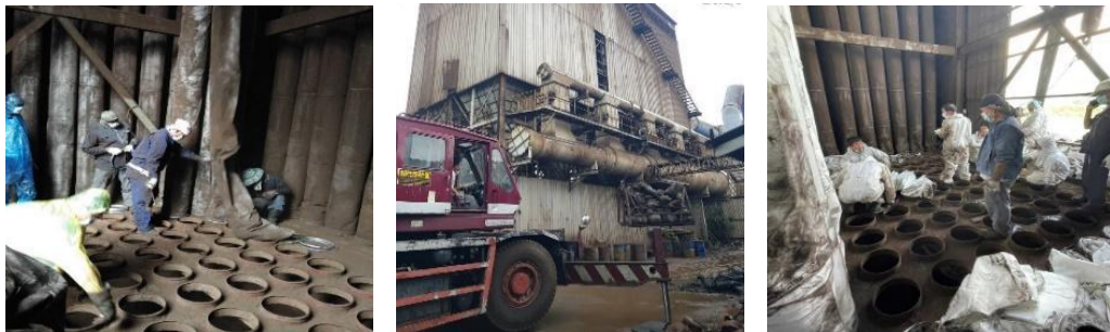
ภาพที่ 2.25 การเปลี่ยนถุงกรองจากระบบบำบัดอากาศ
